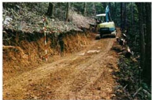
▲崩壊を防ぐため法面は1.5m以下の直切りに。
