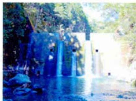
砂防ダム正面から撮影
