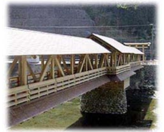
屋根付き木造歩道橋
