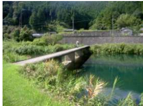
右岸 下流側より (H22.9.14 撮影)
