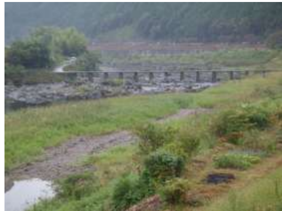
右岸 上流側より (H22.9.27 撮影)
