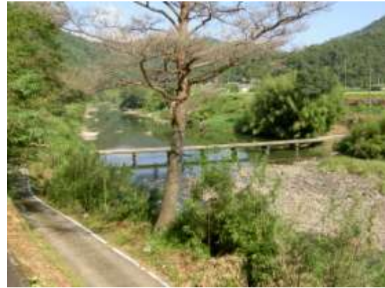
右岸 下流側より (H22.9.14 撮影)
