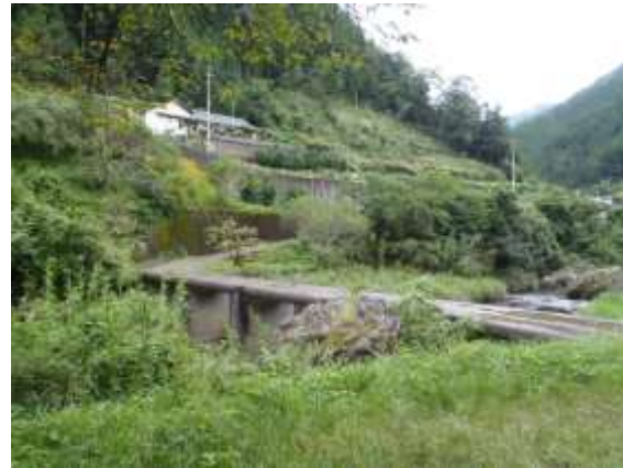
右岸 上流側より (H22.9.13 撮影)
