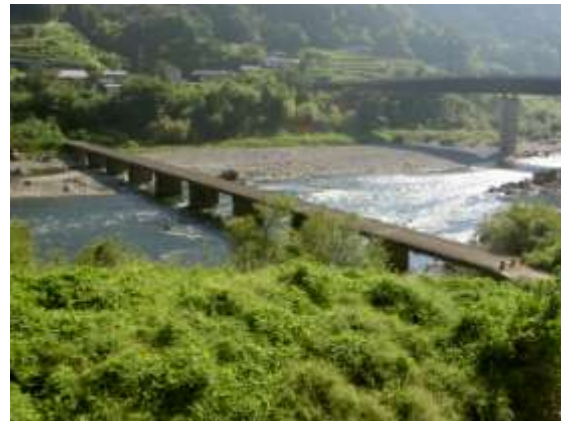
右岸 上流側より (H22.9.14 撮影)
