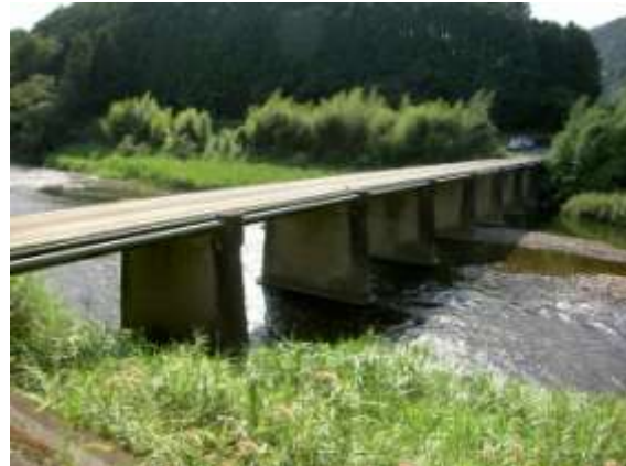
右岸 下流側より (H22.9.14 撮影)
