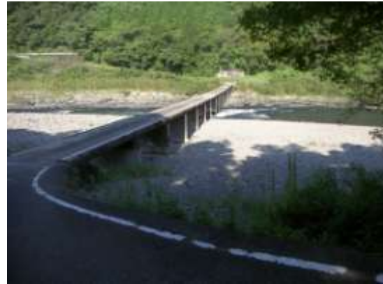
左岸 上流側より (H22.9.14 撮影)
