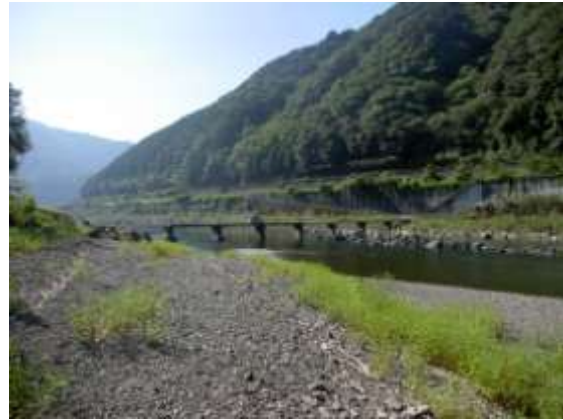
左岸 上流側より (H22.9.14 撮影)
