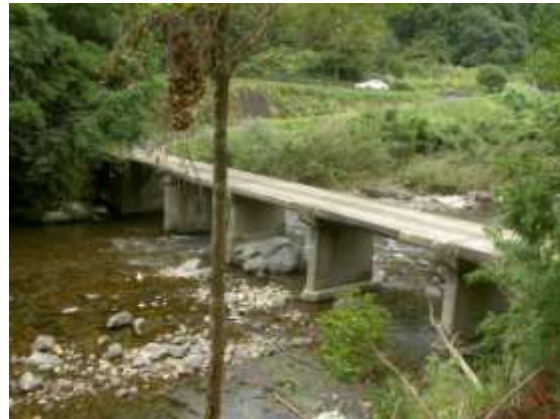
右岸 上流側より (H22.9.13 撮影)
