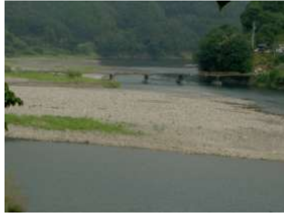
右岸 下流側より (H22.9.13 撮影)
