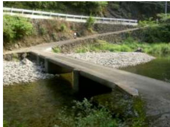
右岸 上流側より (H22.9.13 撮影)
