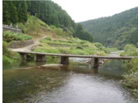
右岸 上流側より (H22.9.13 撮影)
