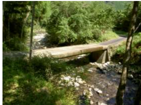
左岸 上流側より (H22.9.14 撮影)
