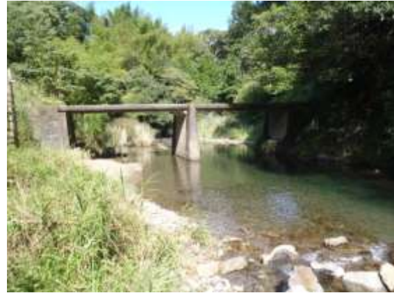
左岸 上流側より (H22.9.14 撮影)
