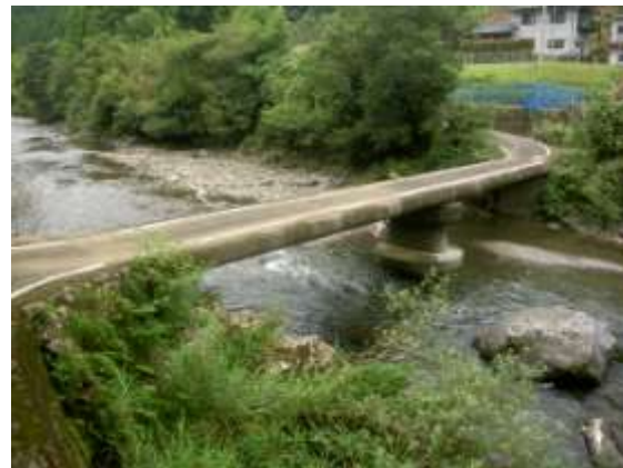
右岸 下流側より (H22.9.13 撮影)
