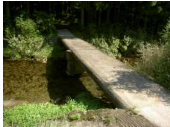
右岸 上流側より (H22.9.14 撮影)
