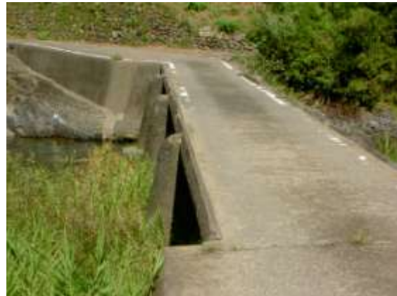
左岸側より (H22.9.14 撮影)
