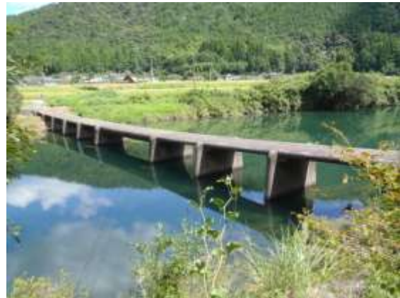
右岸 上流側より (H22.9.14 撮影)
