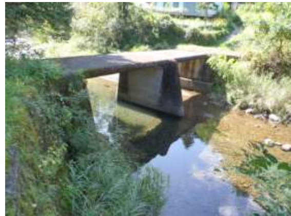
右岸 下流側より (H22.9.14 撮影)
