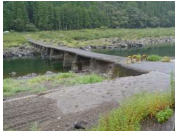
右岸 上流側より (H22.9.27 撮影)
