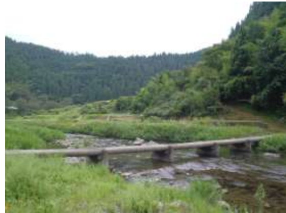
左岸 上流側より (H.22.9.13 撮影)
