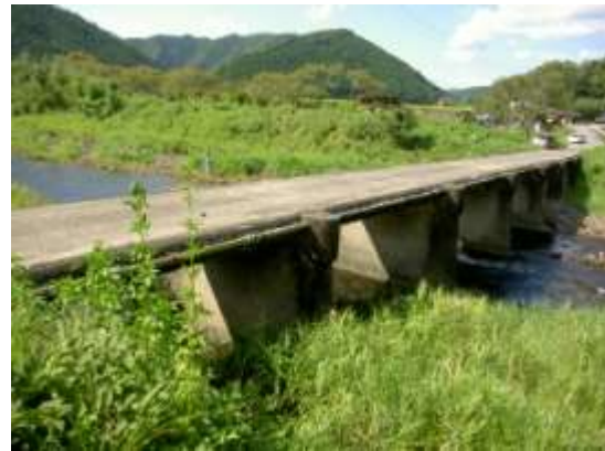
右岸 下流側より (H22.9.14 撮影)
