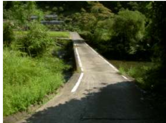
左岸側より (H22.9.14 撮影)
