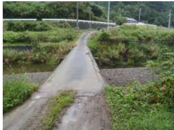
左岸側より (H22.9.27 撮影)
