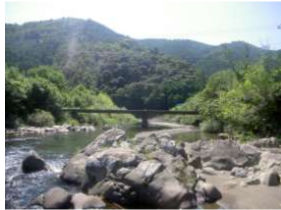
右岸 上流側より (H22.9.14 撮影)
