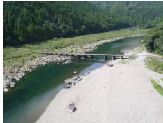
右岸 上流側より (H22.9.16 撮影)
