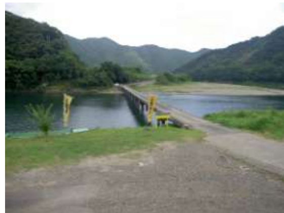
右岸 上流側より (H22.9.13 撮影)
