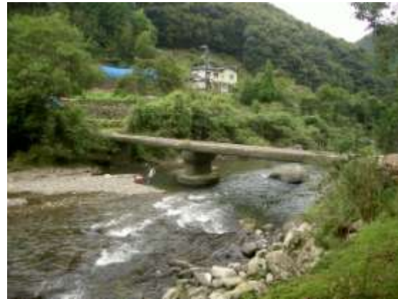
右岸 上流側より (H22.9.13 撮影)
