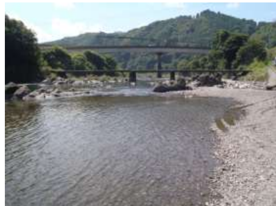
右岸 上流側より (H22.9.16 撮影)
