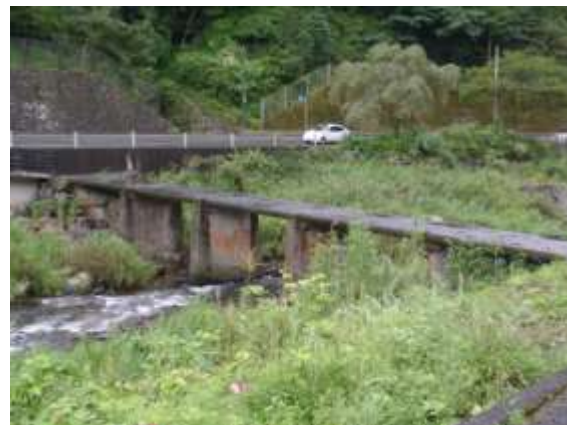
右岸 上流側より (H22.9.13 撮影)
