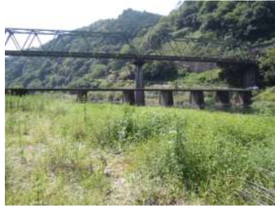
左岸 上流側より (H22.9.16 撮影)
