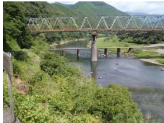
右岸 下流側より (H22.9.16 撮影)
