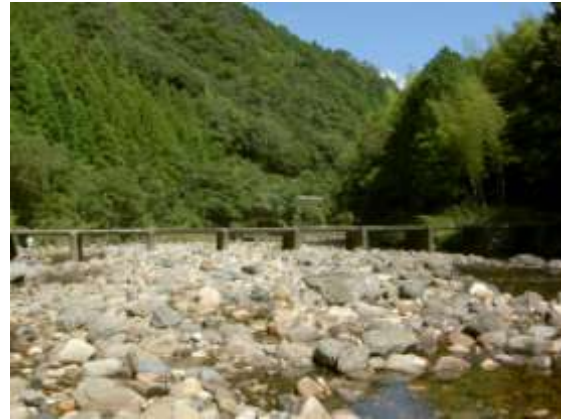
左岸 上流側より (H22.9.14 撮影)
