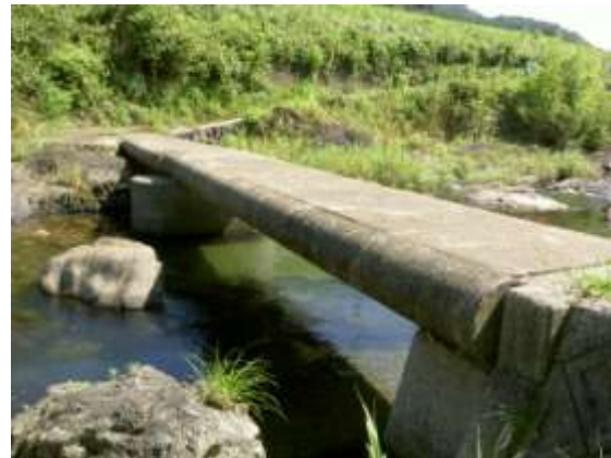
右岸 上流側より (H22.9.14 撮影)
