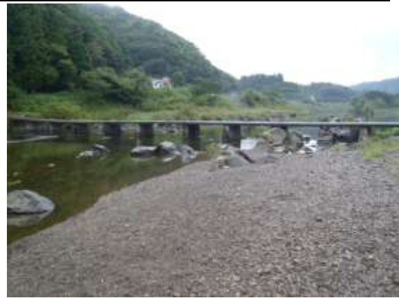
右岸 上流側より (H22.9.27 撮影)
