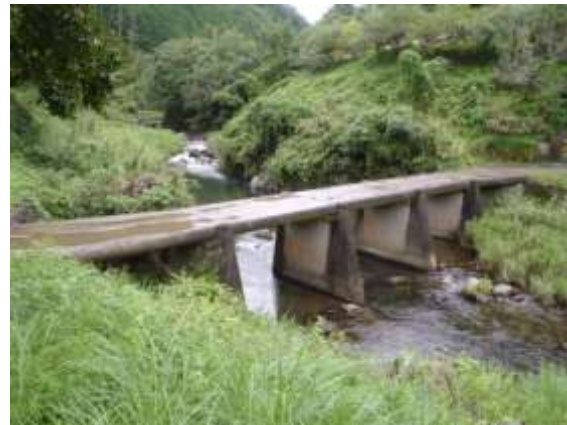
右岸 下流側より (H22.9.13 撮影)
