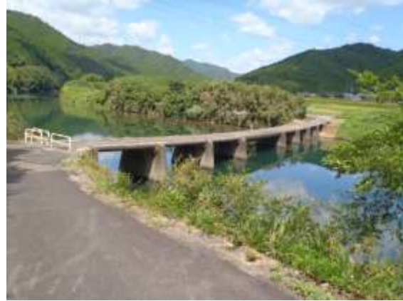
右岸 下流側より (H22.9.14 撮影)
