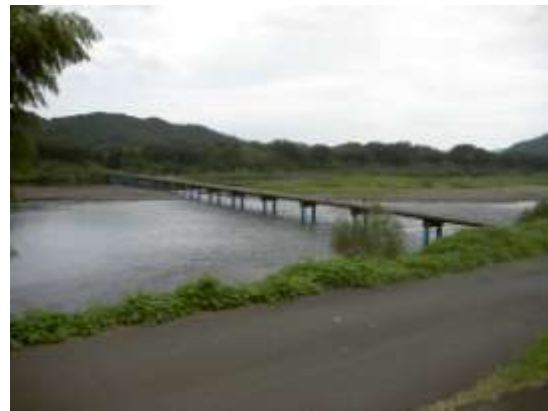
右岸 上流側より (H22.9.13 撮影)
