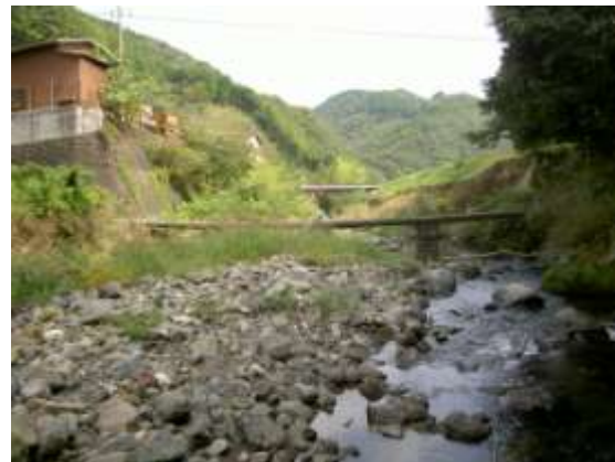
右岸 上流側より (H22.9.16 撮影)
