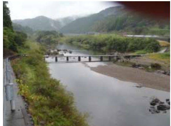
右岸 下流側より (H22.9.27 撮影)
