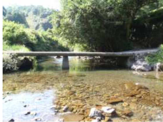
下流側より (H22.9.14 撮影)
