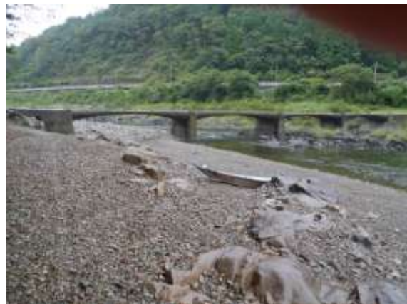
左岸 上流側より (H22.9.27 撮影)
