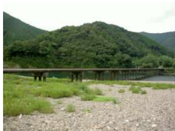
左岸 上流側より (H22.9.13 撮影)
