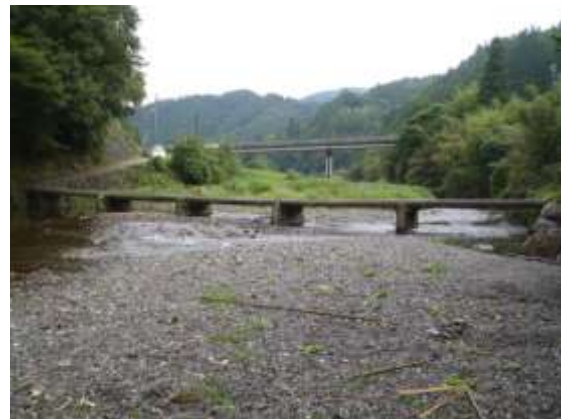
右岸 上流側より (H22.9.13 撮影)
