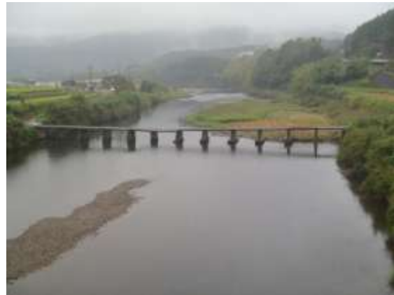
右岸 上流側より (H22.9.27 撮影)
