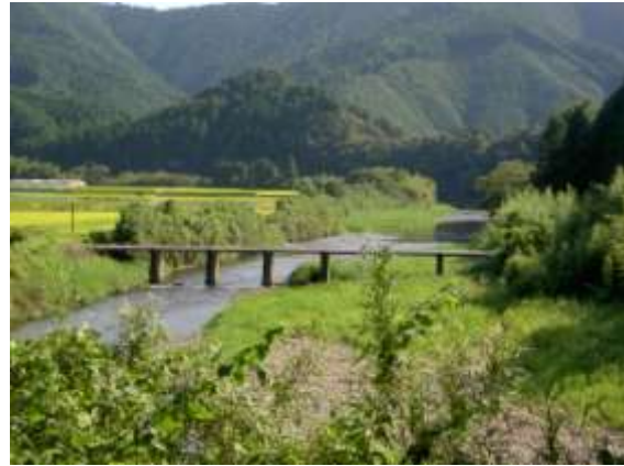
右岸 下流側より (H22.9.14 撮影)
