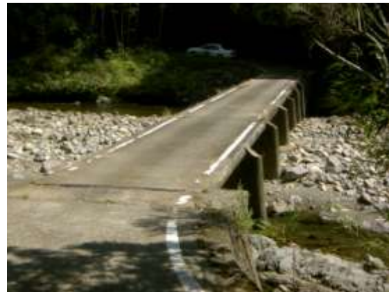
右岸 下流側より (H22.9.14 撮影)
