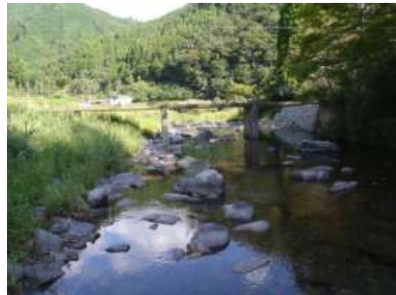
左岸 上流側より (H22.9.13 撮影)
