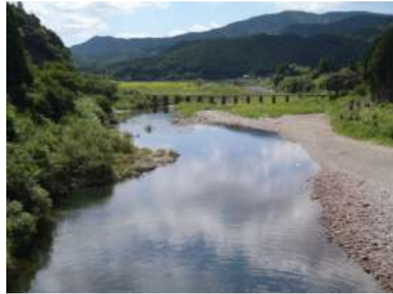
左岸 上流側より (H22.9.14 撮影)
