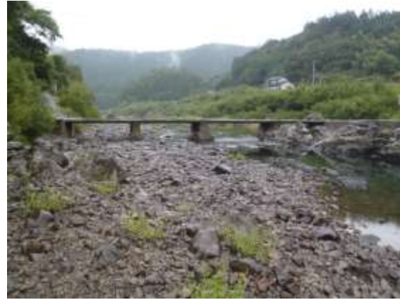
左岸 上流側より (H.22.9.27 撮影)
