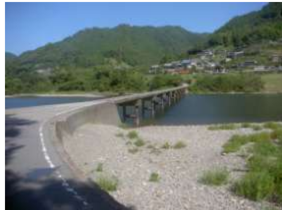
右岸 下流側より (H22.9.14 撮影)
