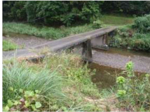
右岸 下流側より (H22.9.27 撮影)
