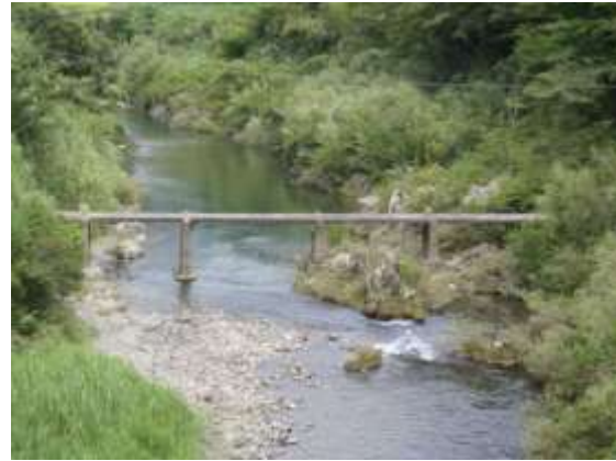
左岸 上流側より (H.22.9.13 撮影)
