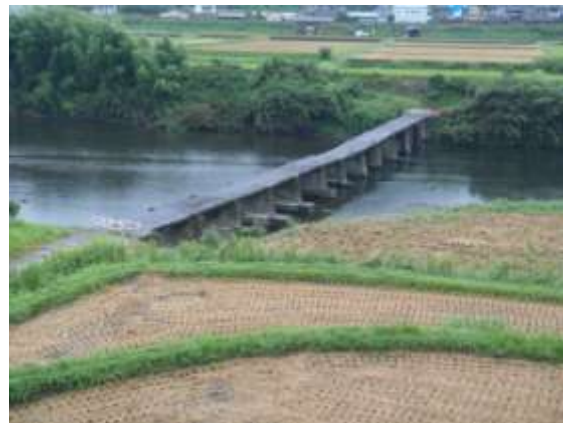
右岸 下流側より (H22.9.27 撮影)
