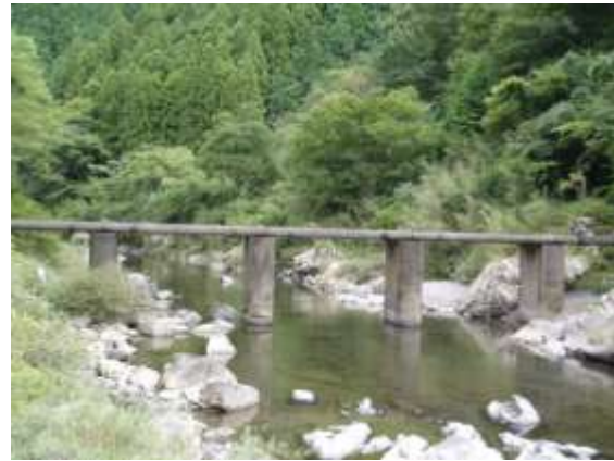
左岸 上流側より (H.22.9.13 撮影)
