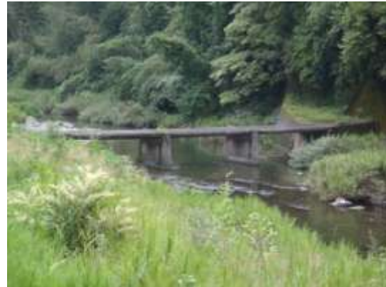
左岸 上流側より (H22.9.13 撮影)
