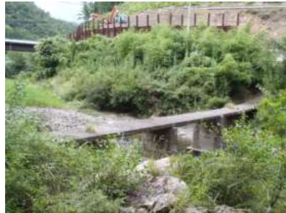
右岸 下流側より (H.22.9.13 撮影)
