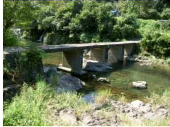
右岸 下流側より (H22.9.14 撮影)
