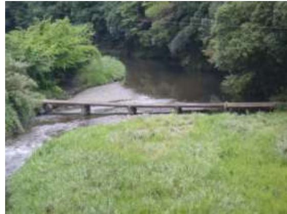
左岸 下流側より (H22.9.13 撮影)
