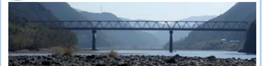
屋内大橋（口屋内沈下橋）から見た口屋内大橋
