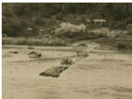
建設中に水没する屋内大橋
