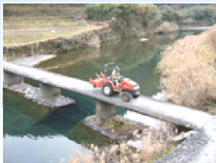
↑ 旧堰の上に作られた高樋沈下橋
