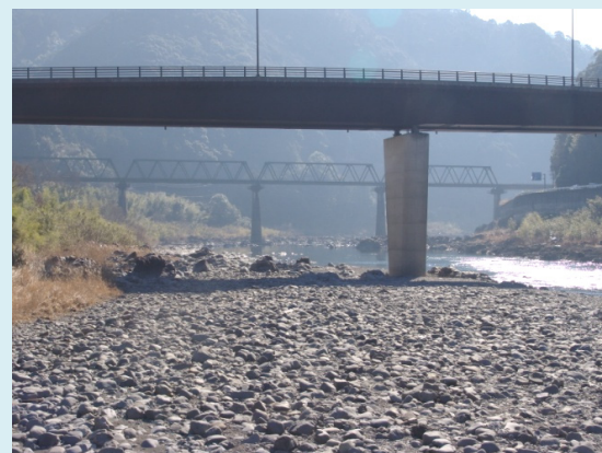
中半家沈下橋からは、抜水橋・JR予土線鉄橋が見える
