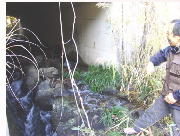
小動物が移動できるように、石が敷かれたボックスカルバート（人工のけもの道）
