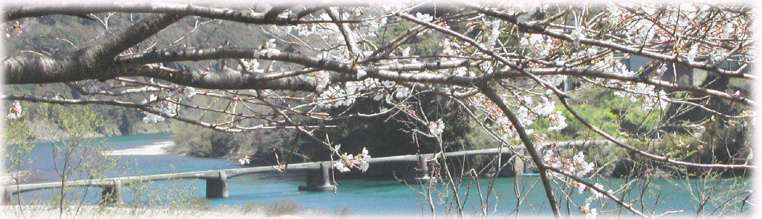
春の口屋内沈下橋（現在は修復中です。）
