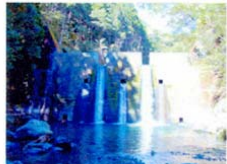
砂防ダム正面から撮影
