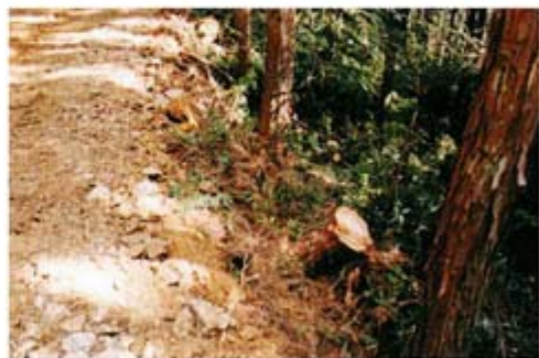
▲土留めに埋め込まれた広葉樹の切り株。
