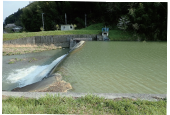
三間川可動堰（愛媛県南予地方局）
