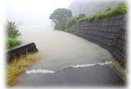
上岡沈下橋へ向かう歩道
