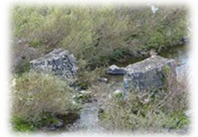
板橋の橋脚.JPG
