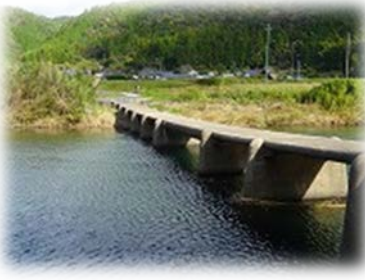
一斗俵沈下橋.JPG
