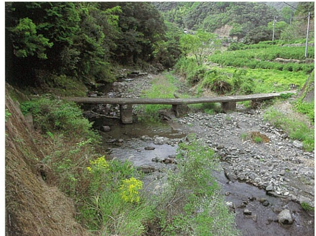
左岸下流側より (H22.9.16撮影)
