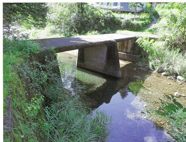
右岸下流側より (H22.9.14撮影)
