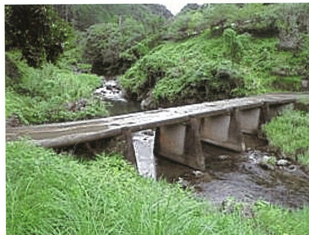
右岸下流側より (H22.9.13撮影)
