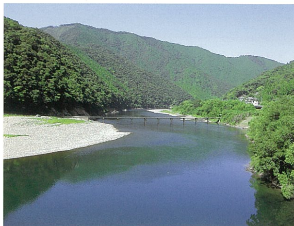
左岸下流側より (H22.9.14撮影)
