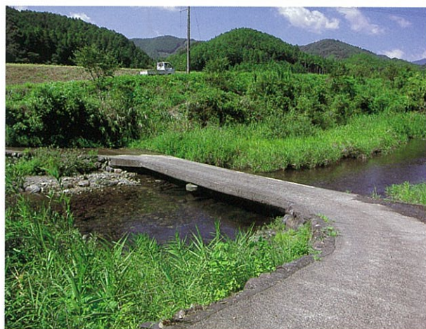
左岸下流側より (H22.9.14撮影)
