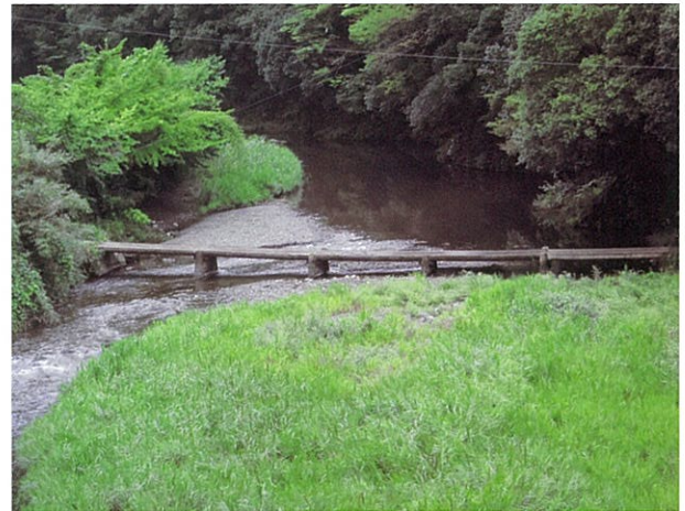
左岸下流側より (H22.9.13撮影)
