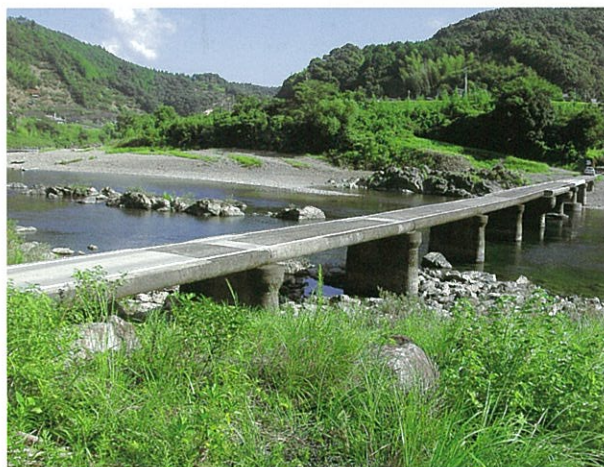
右岸下流側より (H22.9.14撮影)
