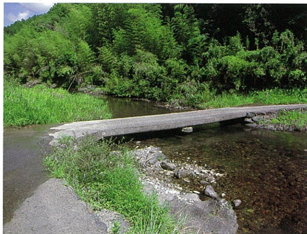
右岸下流側より (H22.9.14撮影)
