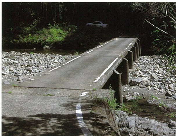
右岸下流側より (H22.9.14撮影)
