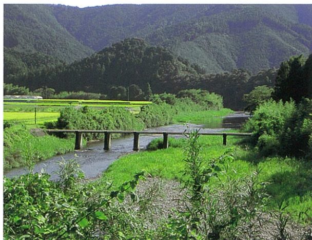
右岸下流側より (H22.9.14撮影)
