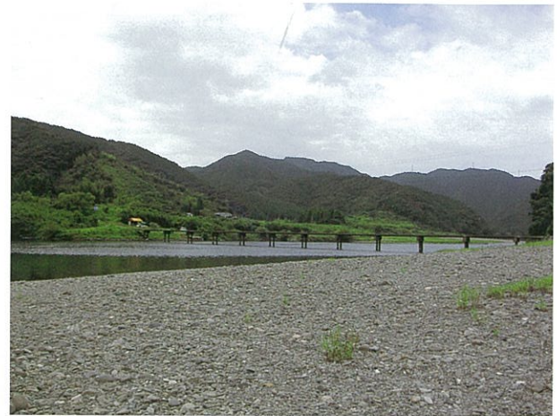
左岸下流側より (H22.9.13撮影)
