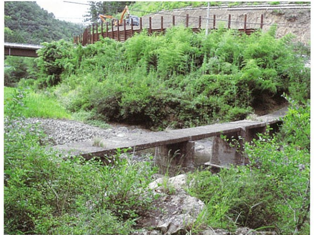
右岸下流側より (H.22.9.13撮影)
