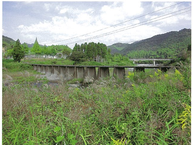
左岸下流側より (H22.9.14撮影)
