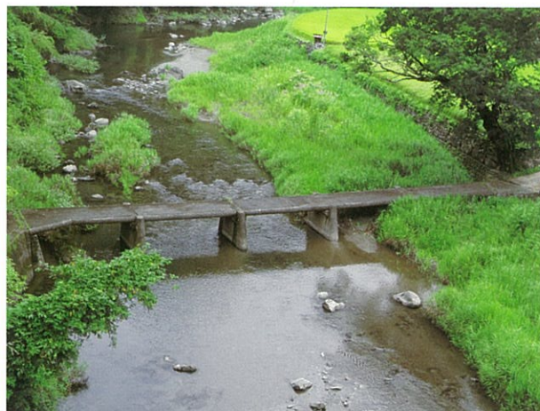
右岸 下流側より (H22.9.13撮影)
