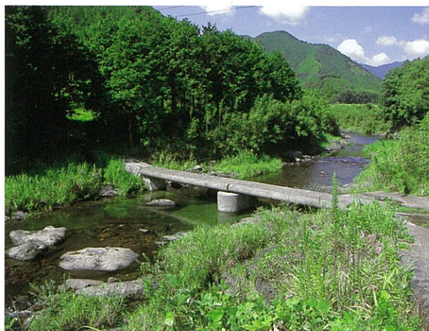
左岸下流側より (H22.9.14撮影)
