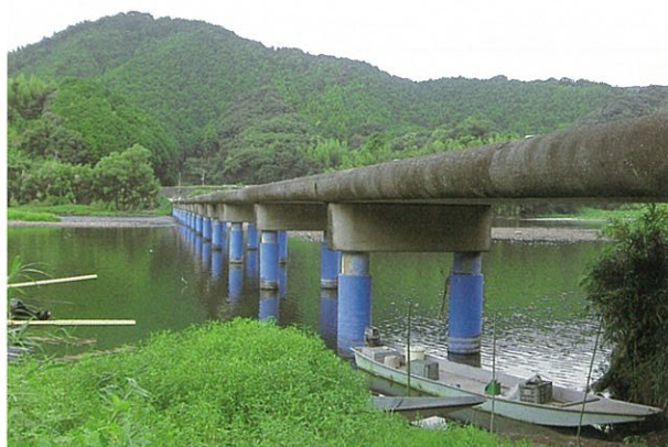
左岸下流側より (H22.9.13撮影)
