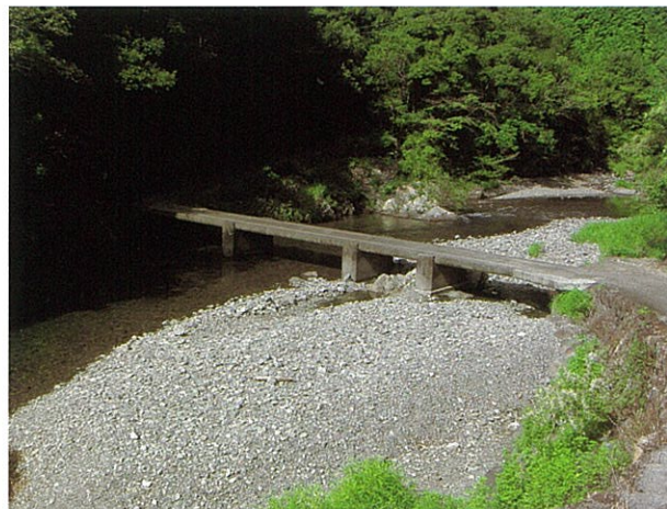
左岸下流側より (H22.9.13撮影)
