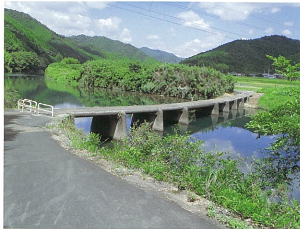
右岸下流側より (H22.9.14撮影)
