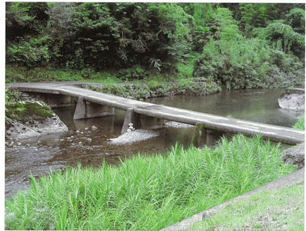
左岸下流側より (H22.9.13撮影)
