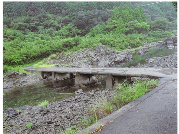
左岸下流側より (H.22.9.27撮影)
