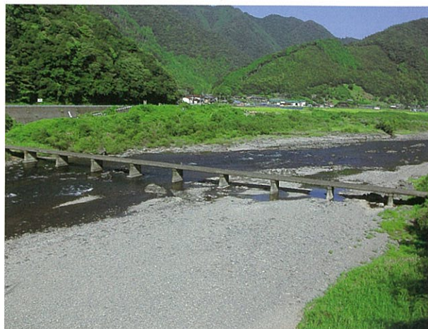
左岸下流側より(H22.9.14撮影)
