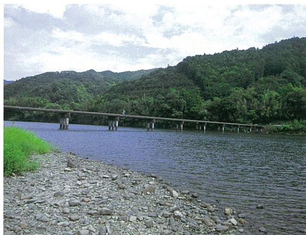
右岸下流側より (H22.9.13撮影)
