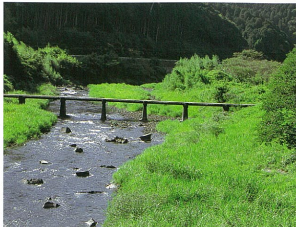
左岸下流側より (H22.9.14撮影)
