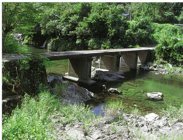
右岸下流側より (H22.9.14撮影)
