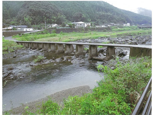
左岸下流側より (H22.9.27撮影)
