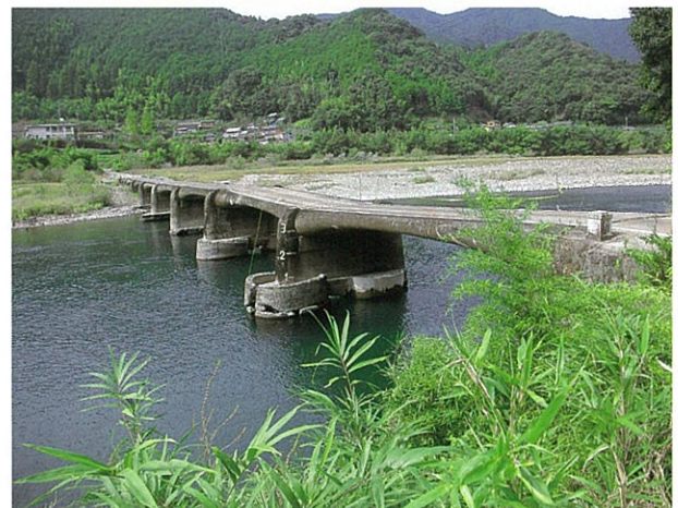
左岸下流側より (H22.9.13撮影)
