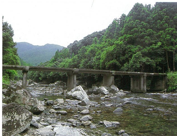
右岸下流側より (H22.9.13撮影)
