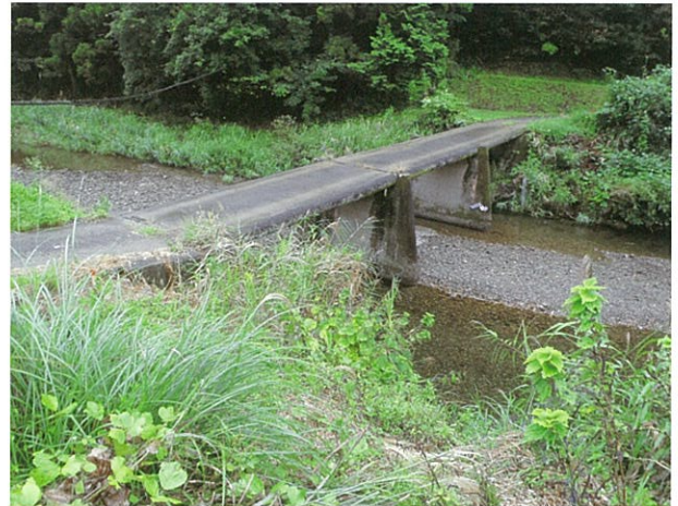
右岸下流側より (H22.9.27撮影)
