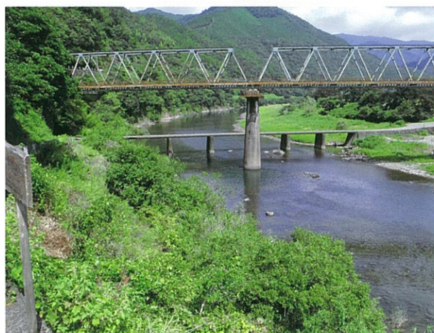
右岸下流側より (H22.9.16撮影)
