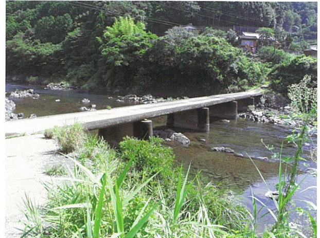
右岸下流側より (H22.9.16撮影)
