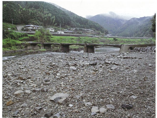
左岸下流側より (H22.9.27撮影)
