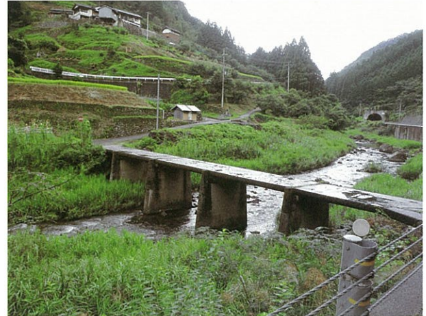
左岸下流側より (H22.9.13撮影)
