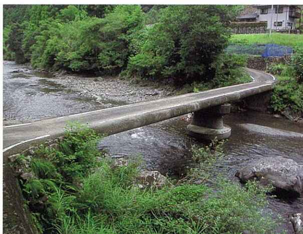
右岸下流側より (H22.9.13撮影)
