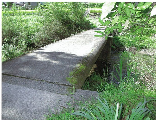
左岸下流側より (H22.9.14撮影)
