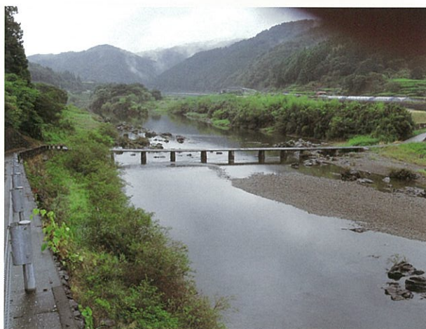
右岸下流側より (H22.9.27撮影)
