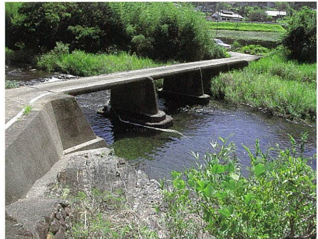
右岸下流側より (H22.9.14撮影)
