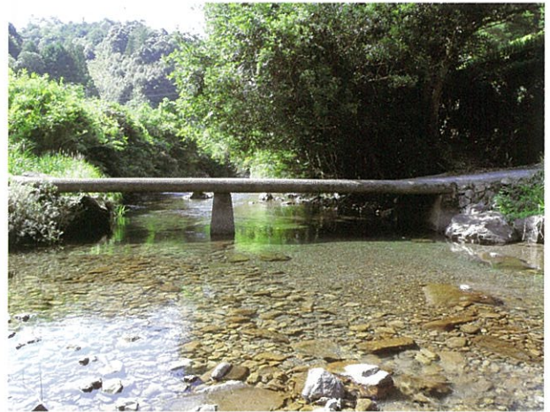
下流側より (H22.9.14撮影)
