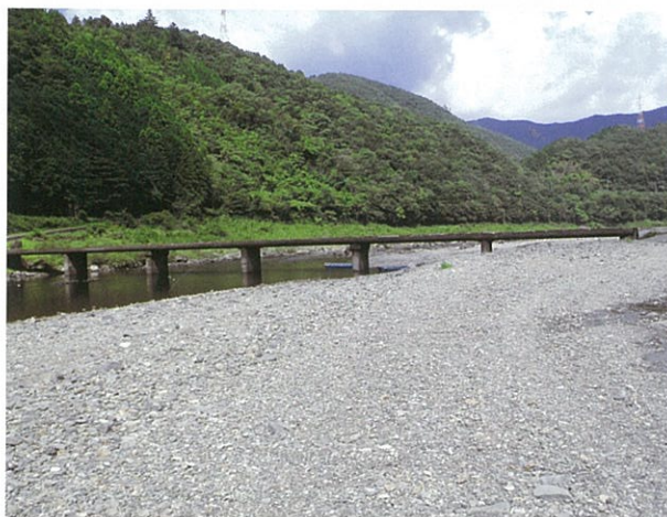
左岸下流側より (H22.9.16撮影)
