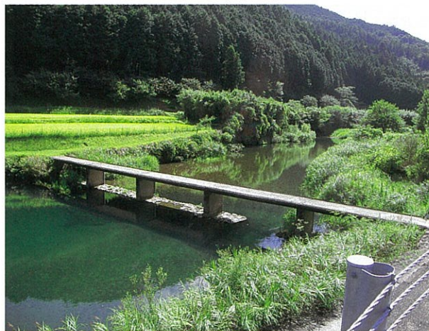
左岸下流側より (H22.9.14撮影)
