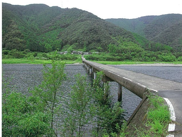
左岸下流側より (H22.9.13撮影)
