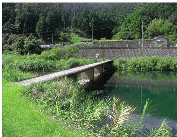
右岸下流側より (H22.9.14撮影)
