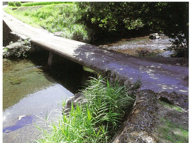
左岸 下流側より (H22.9.14撮影)
