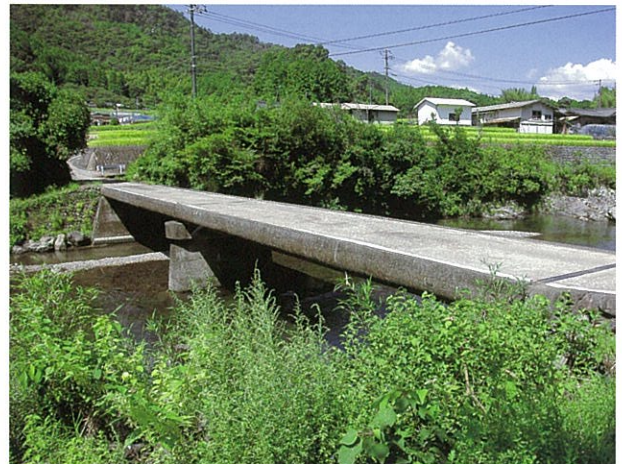
左岸下流側より (H22.9.14撮影)
