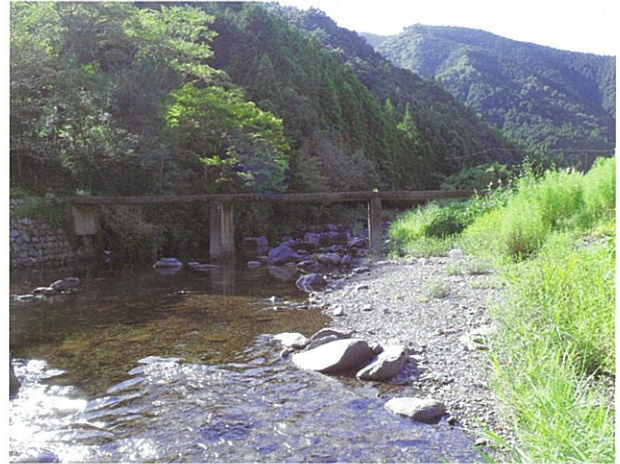
左岸下流側より (H22.9.13撮影)
