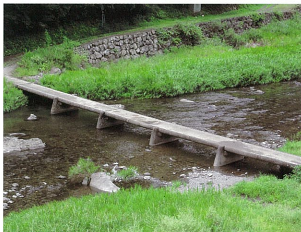
左岸下流側より (H.22.9.13 撮影)
