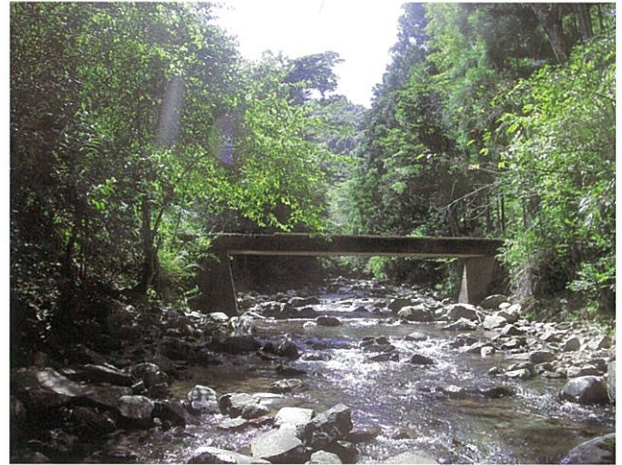
右岸下流側より (H22.9.14撮影)
