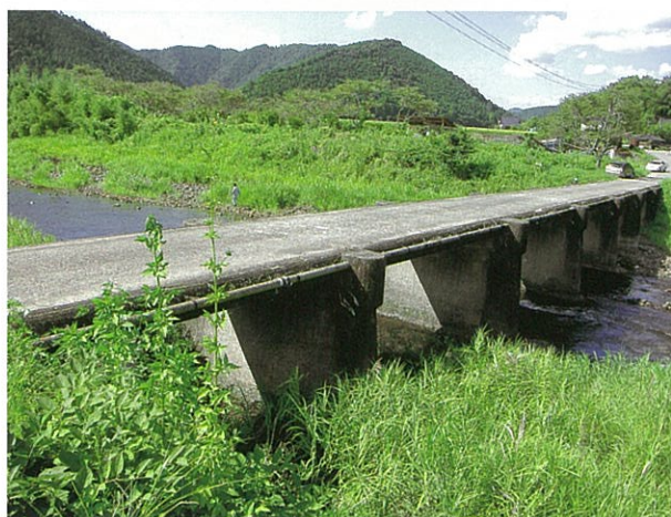
右岸下流側より (H22.9.14撮影)
