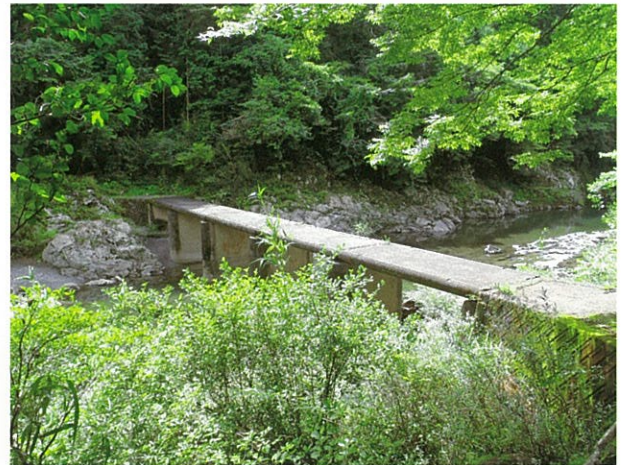
左岸下流側より (H.22.9.13撮影)
