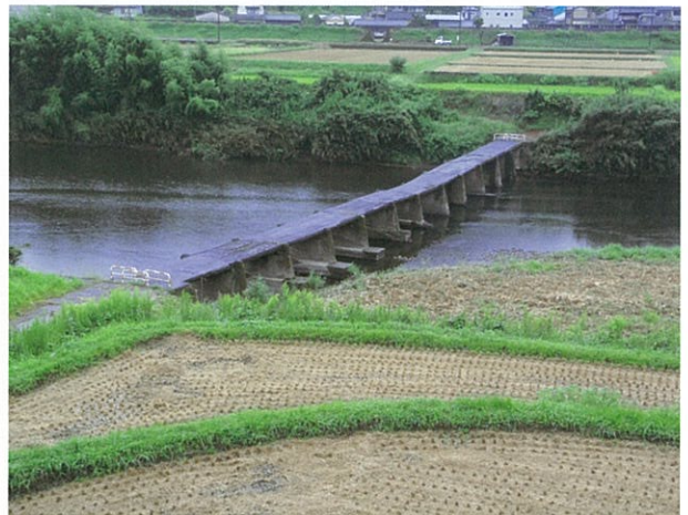
右岸下流側より (H22.9.27撮影)
