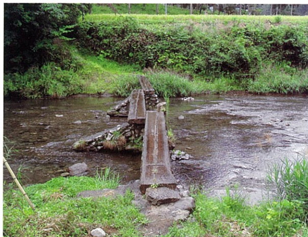
右岸側より (H22.9.27撮影)
