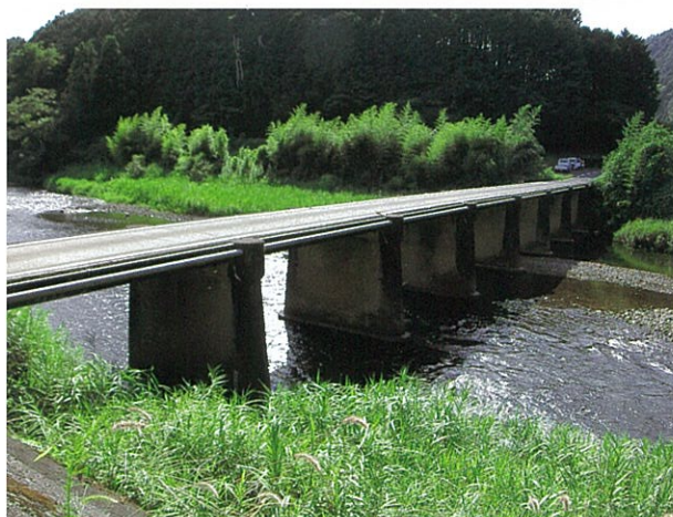
右岸下流側より (H22.9.14撮影)
