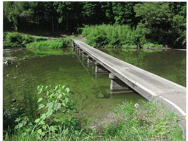
左岸下流側より (H22.9.14撮影)
