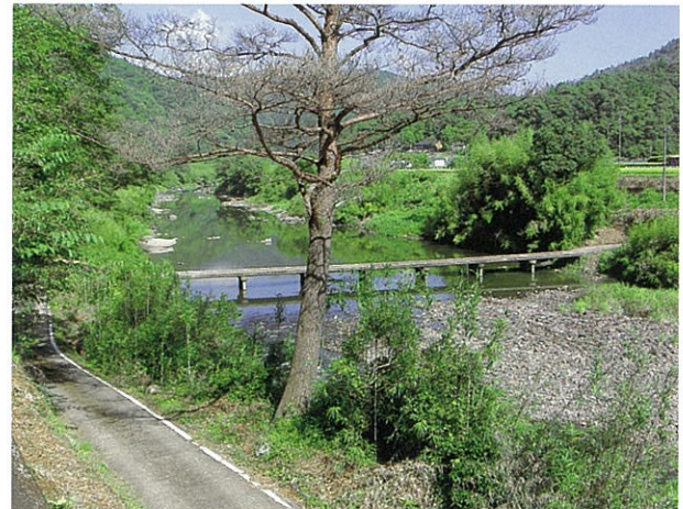
右岸下流側より (H22.9.14撮影)
