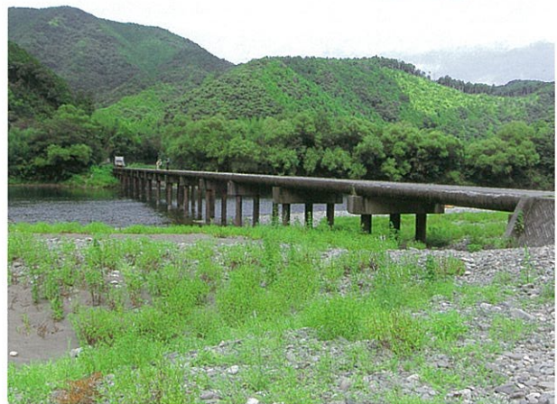
左岸下流側より (H22.9.13撮影)
