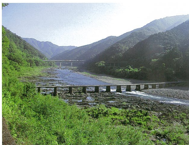
右岸下流側より (H22.9.14撮影)
