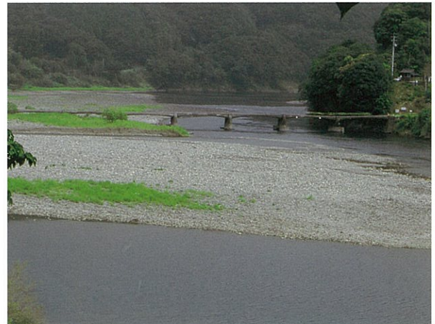
右岸下流側より (H22.9.13撮影)
