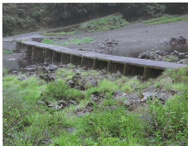
左岸下流側より (H22.9.27撮影)
